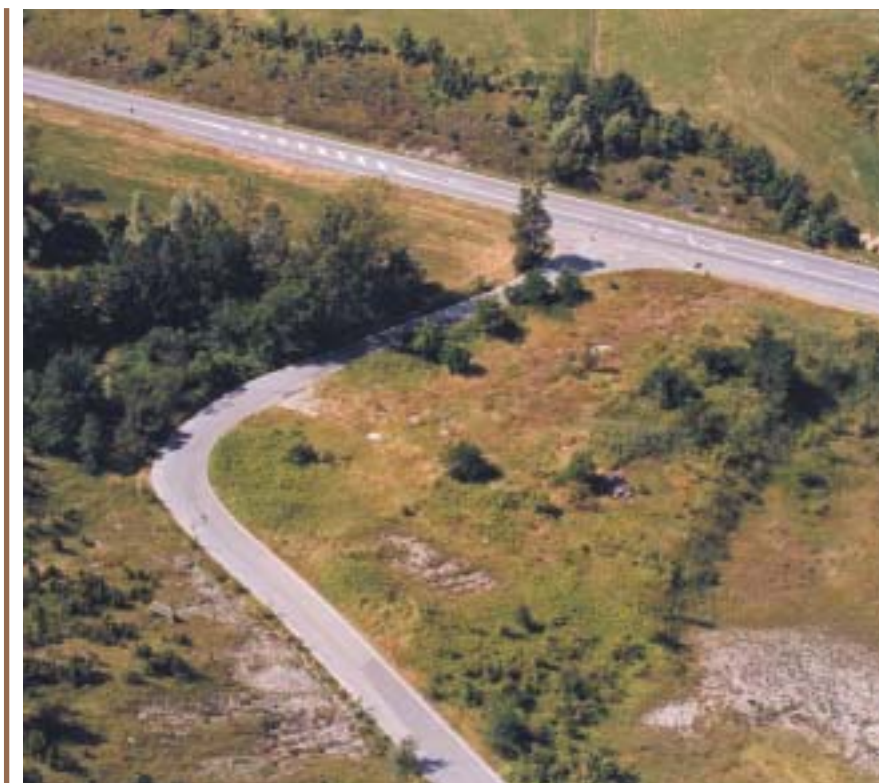
Intervento di consolidamento di scarpata stradale della S.S. "Nuova Estense" con viminate in comune di Serramazzone (Mo), loc. bivio per Riccò (anno 1981); nella foto che segue, realizzata circa vent'anni dopo, è possibile riscontrare gli efficaci effetti dell'intervento.
