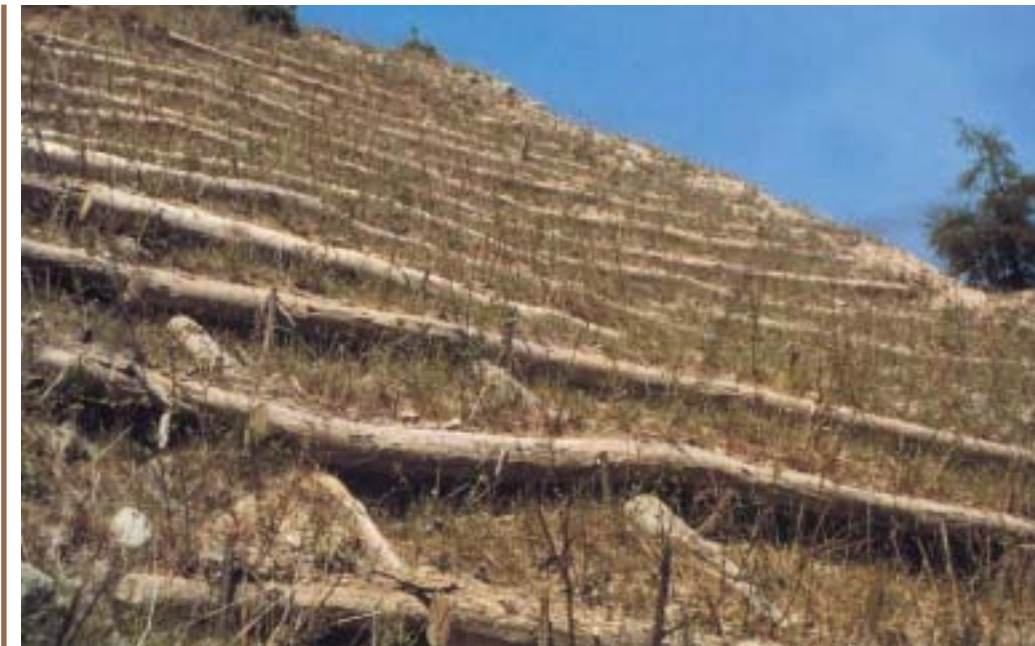
Grata in legname con talee e piantine a consolidamento di una frana ( Frana S. Martino, Lasa - Bz ) dopo 1 anno.
