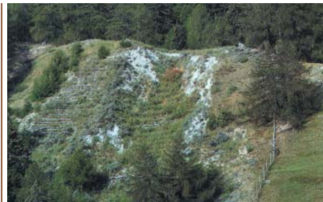
Grata in legname con talee e piantine a consolidamento di una frana, dopo 7 anni.
