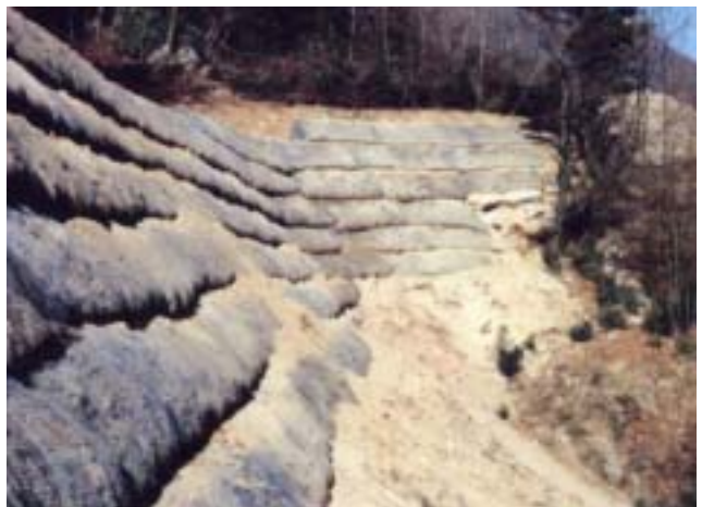
Fase di realizzazione di un rilevato paramassi in terre rinforzate con geosintetici in ambiente montano
