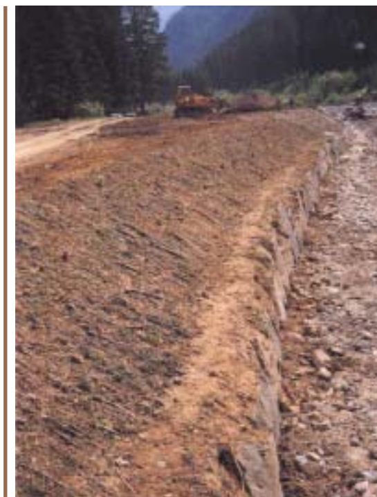
Intervento di consolidamento spondale di torrente ( Torrente Biois, Agordino - Bl ): copertura diffusa con astoni di salice (fase di realizzazione).
