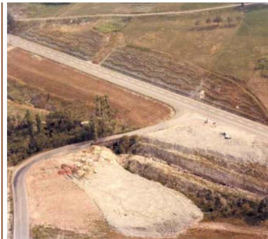
Intervento di consolidamento di scarpata stradale della S.S. "Nuova Estense" con viminate in comune di Serramazzone (Mo), loc. bivio per Riccò (anno 1981); nella foto che segue, realizzata circa vent'anni dopo, è possibile riscontrare gli efficaci effetti dell'intervento.
