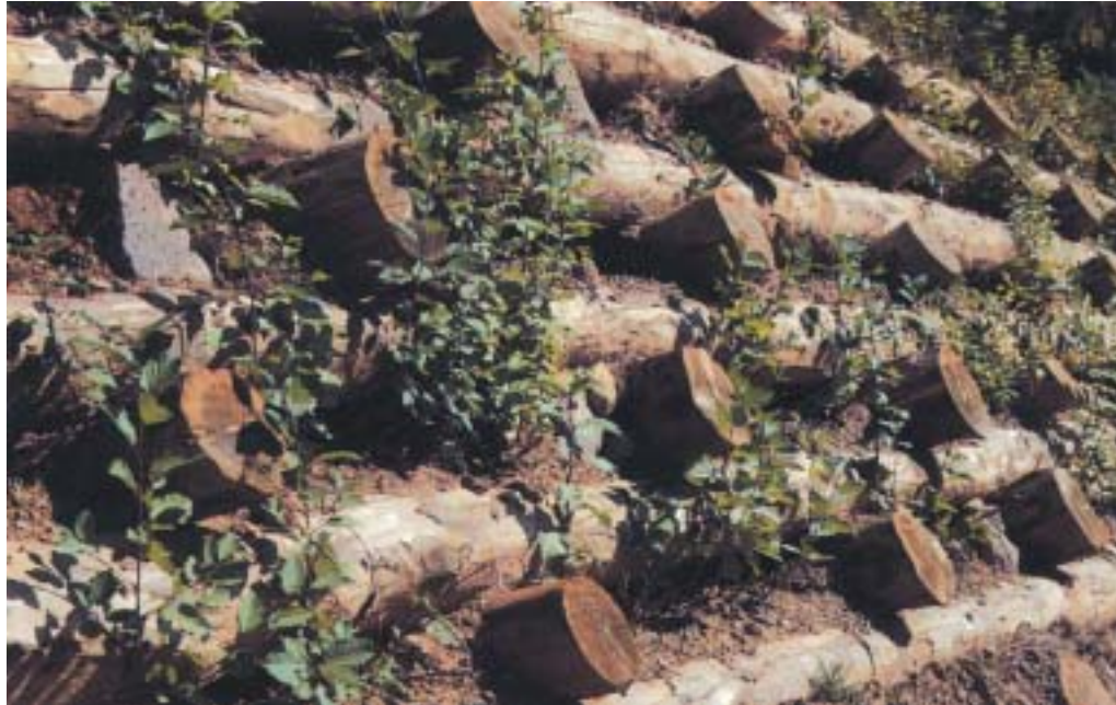
Palificata in legname con messa a dimora di piantine, in fase di costruzione nella precedente immagine, dopo due anni.
