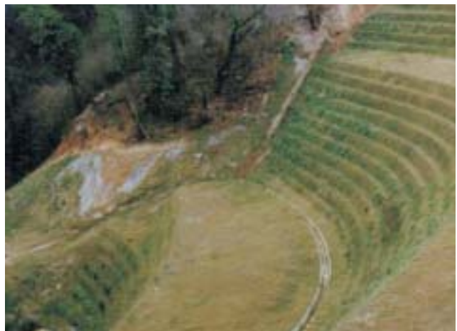
Inerbimento mediante tecnica dell'idrosemina di un'opera di sostegno in terra rinforzata. Nell'immagine si può osservare la buona riuscita dell'intervento a distanza di pochi mesi dall'ultimazione dei lavori
