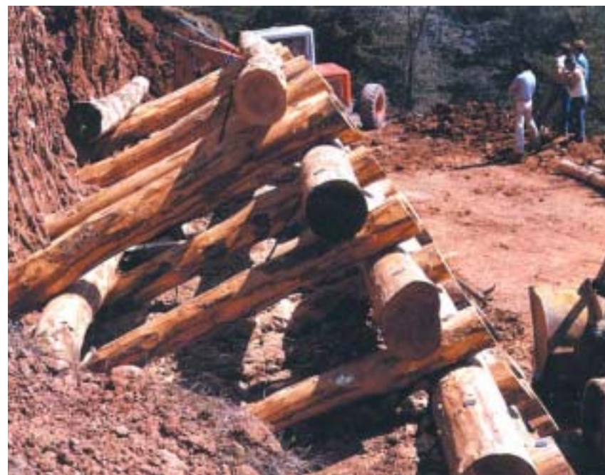
Palificata in legname con messa a dimora di piantine per consolidamento di una frana - fase di realizzazione - (Frana Widmayr, S. Genesio - Bz).
