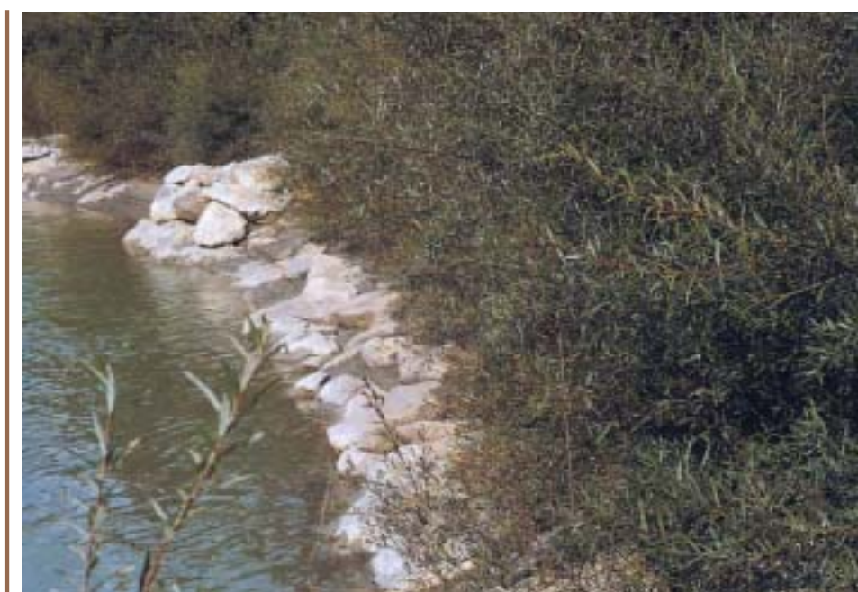
Copertura diffusa con astoni di salice dopo tre anni dall'inizio intervento ( Rio Aurino, Val Pusteria - Bz ).
