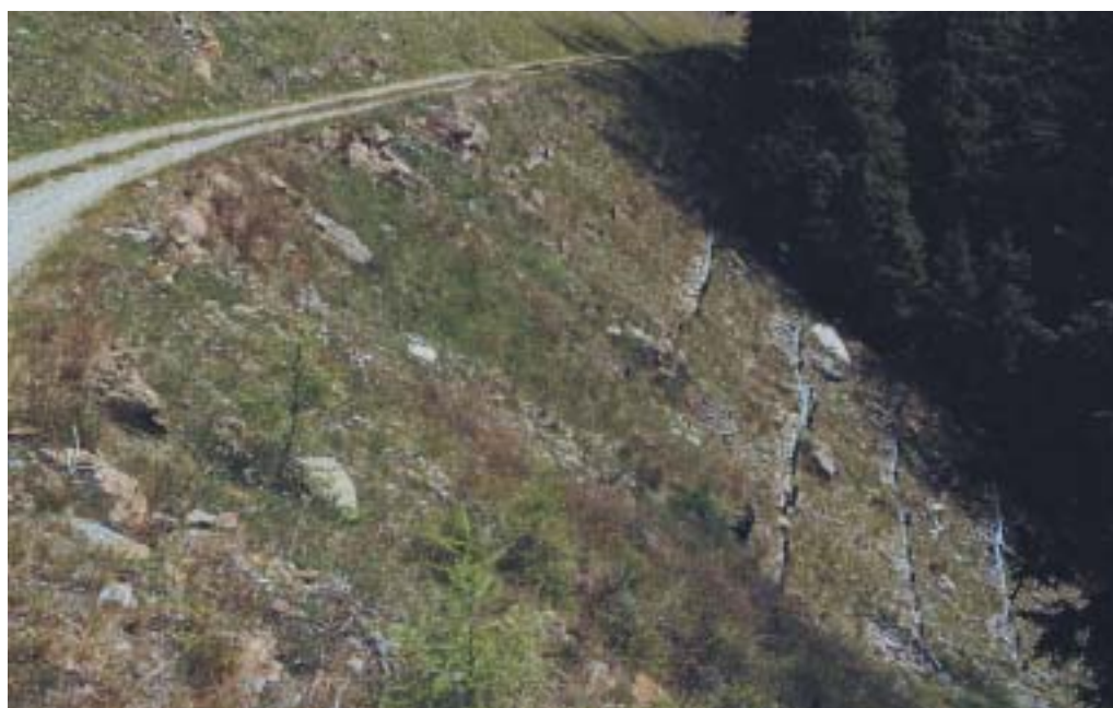
Stesso intervento di consolidamento dopo 8 anni.
