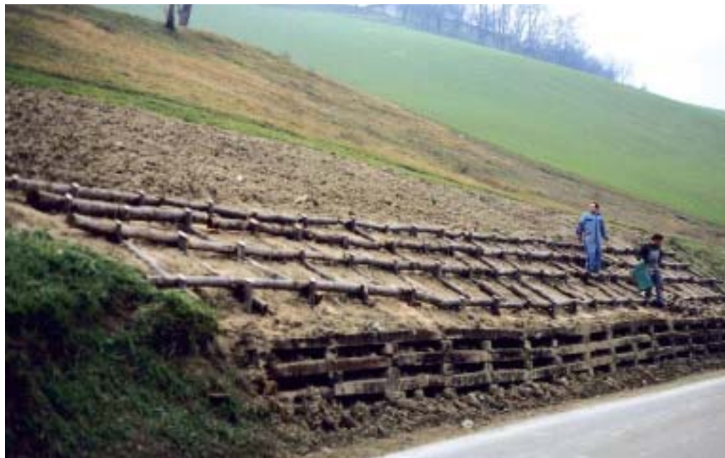
Intervento di consolidamento di scarpata stradale realizzato dalla Provincia di Modena in Comune di Sassuolo (Mo), loc. Cà del Chierico, con palificata e grata in legname nella quale sono state opportunamente messe a dimora piantine. Si noti come per la realizzazione della parte basale dell'opera siano state utilmente reimpiegate vecchie traversine ferroviarie in legno.
