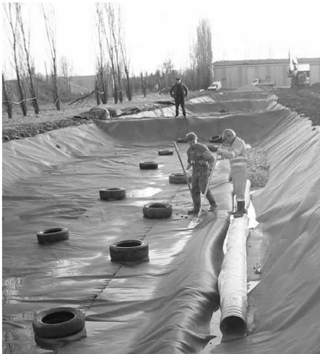
Sono stati posti in opera tubi atti al pescaggio delle acque raccolte nello strato drenante posto subito sopra ai teli in PEAD.
