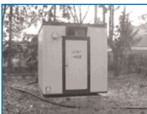
Figura 1 - Centralina di monitoraggio delle acque sotterranee di S. Cesario s.P.
