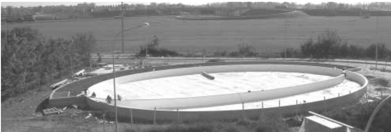
Impianto di fitodepurazione in costruzione
