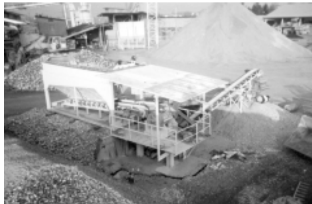
Figura 4. Visione d'insieme dell'impianto.
