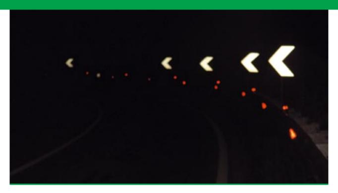
Sistema di segnalazione luminosa-sequenziale di curve pericolose, formato da delineatori modulari di curva ciascuno dei quali corredati di lampada ad alta visibilità.
