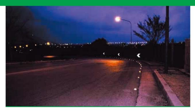
Costi € 3.258,00 Occhi di gatto dotati di corpo e parte rifrangente dello stesso colore della segnaletica orizzontale di cui costituiscono rafforzamento; ottimale per una visibilità notturna da lunghe distanze anche in condizioni di pioggia o nebbia.
