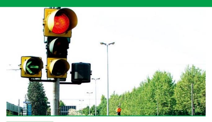
Costi € 29.000,00 Trattasi di impianto semaforico idoneo alla regolazione di intersezione stradale a raso a quattro braccia, e dotato di dispositivo radar di rilevamento della velocità e contestuale attivazione del "rosso" al superamento della velocità consentita.
