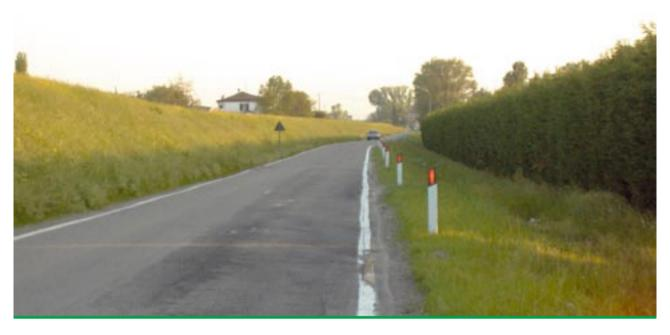
Trattasi di dispositivi segnaletici complementari atti a visualizzare a distanza l'andamento della strada. Sono in materiale plastico, con spigoli arrotondati, altezza 135 cm, di colore bianco con fascia nera alta 25 cm posta nella parte superiore e dotati di dispositivi rifrangenti di superficie di colore rosso sul lato destro e bianco sul lato sinistro del senso di marcia.
