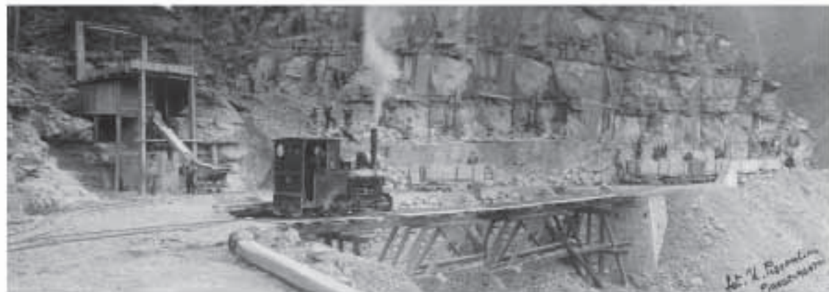
Cantiere di costruzione della diga di Fontanaluccioni Foto Pignatelli- Piantalogosti 1925
