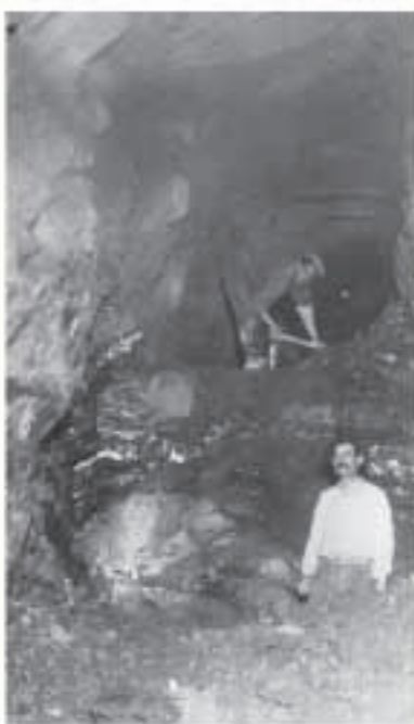
Operai nel corso dello scavo della galleria fra Fontanaluccioni e Farneta
