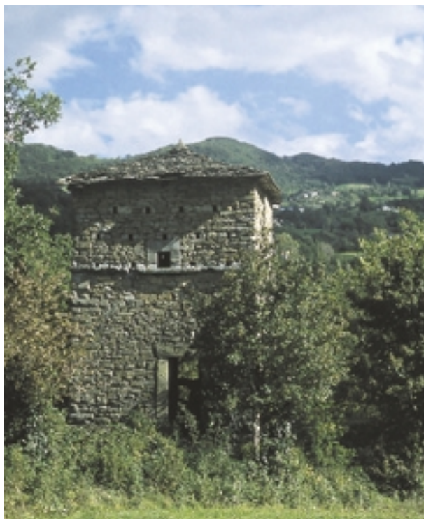
Casa torre dei Mucci
