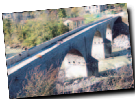
Restaurato il ponte dei Leoni a Strettara
