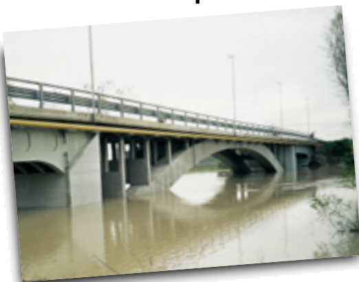
Il Ponte Pioppa al battesimo della piena del Secchia
