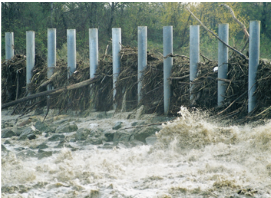
Briglie di contenimento sul Panaro
