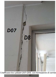
giunti inefficaci tra i pilastri D07-D08, con formazione di cerniera in alto
