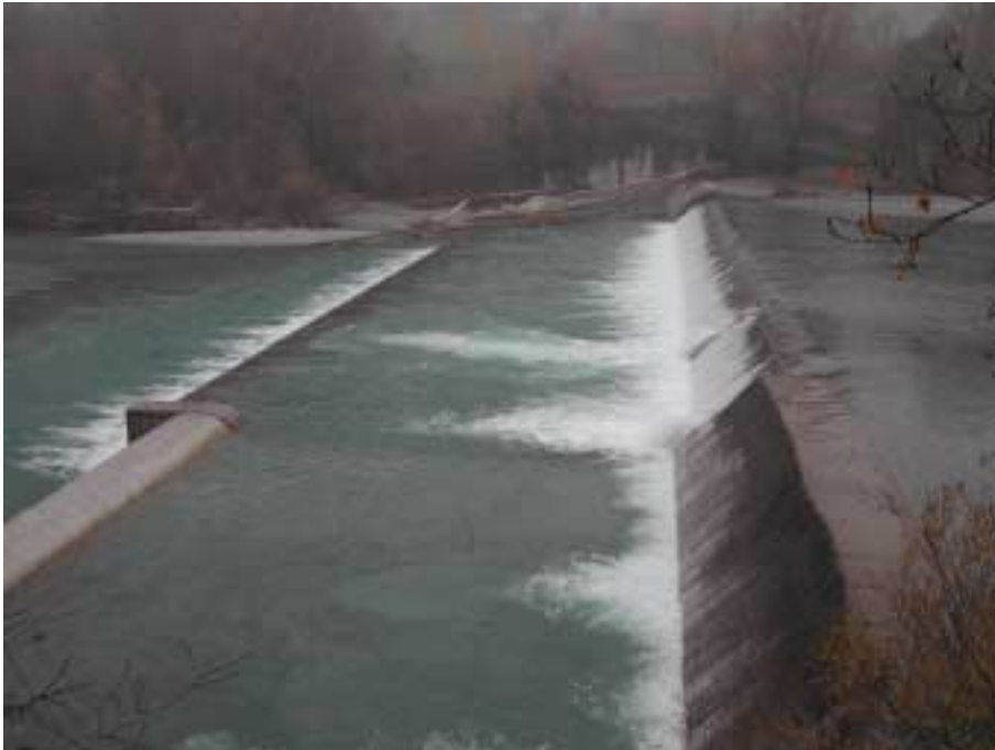
Figura 42. Sbarramento La Casona il giorno 29 Novembre 2004, ore 17.30
