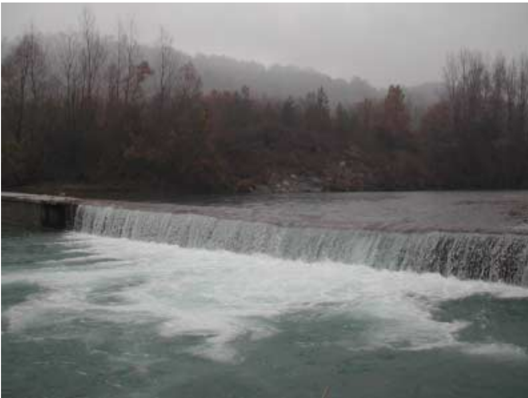
Figura 22. Sbarramento Ponte Samone (foto Pini Prato)
