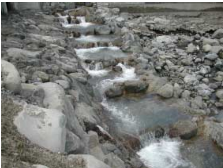
Figura 12. Passaggio "close to nature"- tipologia "fish ramp" con l'utilizzo di massi e ciottoli reperiti in alveo (foto e progetto Pini Prato)
