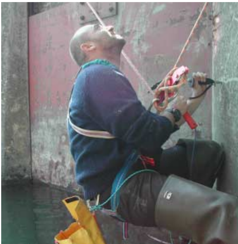
Figura 13. Posizionamento di un'asta idrometrica per il controllo delle variazioni di livello a monte di una traversa di derivazione sul F.Sieve (foto Pini Prato)
