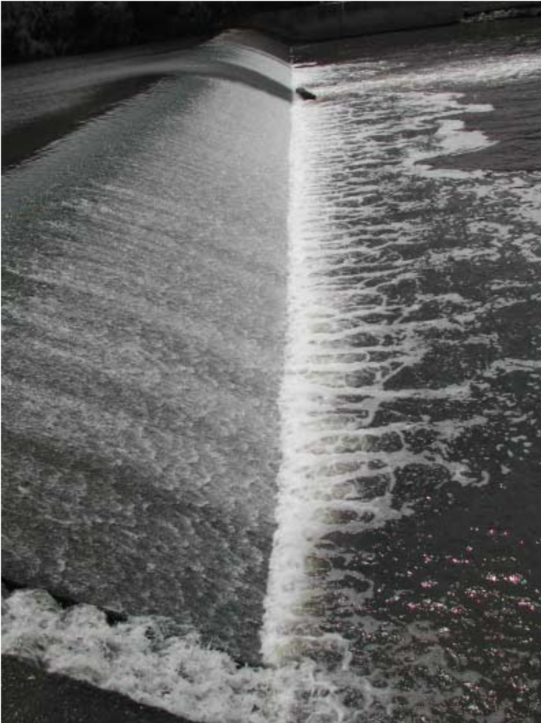
Figura 19. Traversa nel basso corso dell'Arno. L'ombra nera ai piedi del manufatto è un banco di muggini in tentativo di rimonta: l'altezza dello sbarramento e l'inadeguatezza del passaggio artificiale rendono tuttavia impossibile la migrazione (foto Pini Prato)
