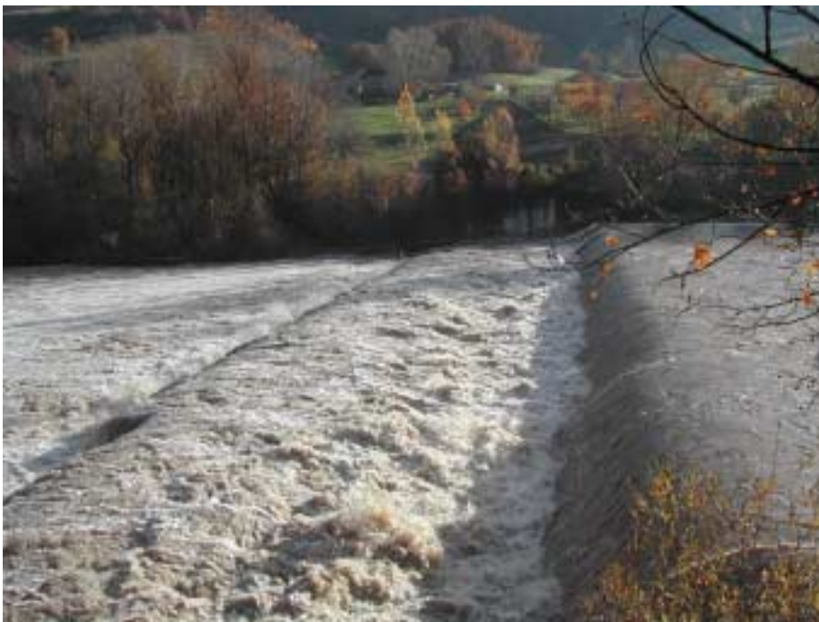
Figura 43. Lo stesso sbarramento la mattina del 30 Novembre dopo una notte di pioggia: si noti il rilevante aumento di portata
