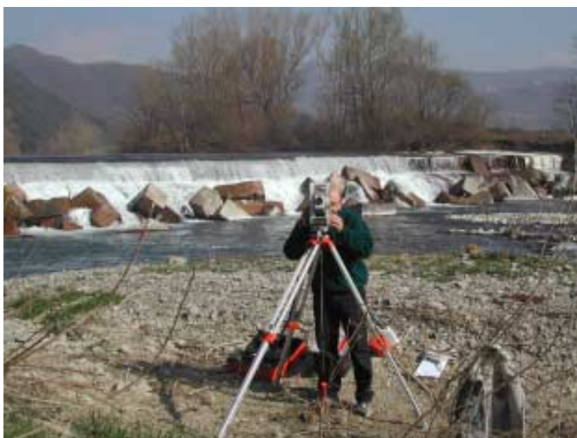
Figura 14. Rilievo topografico eseguito con stazione totale nell'area in cui verrà realizzato il P.p.P. Fiume Sieve, Firenze (foto Pini Prato)
