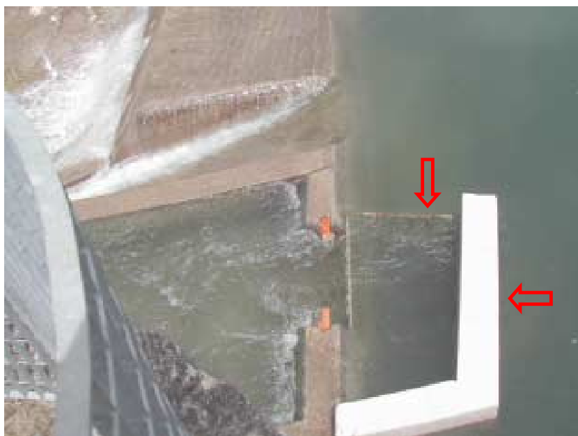
Figura 9. Pennello e grigliato protettivo alla presa d'acqua di un P.p.P. sul T.Lima (foto e progetto Pini Prato)
