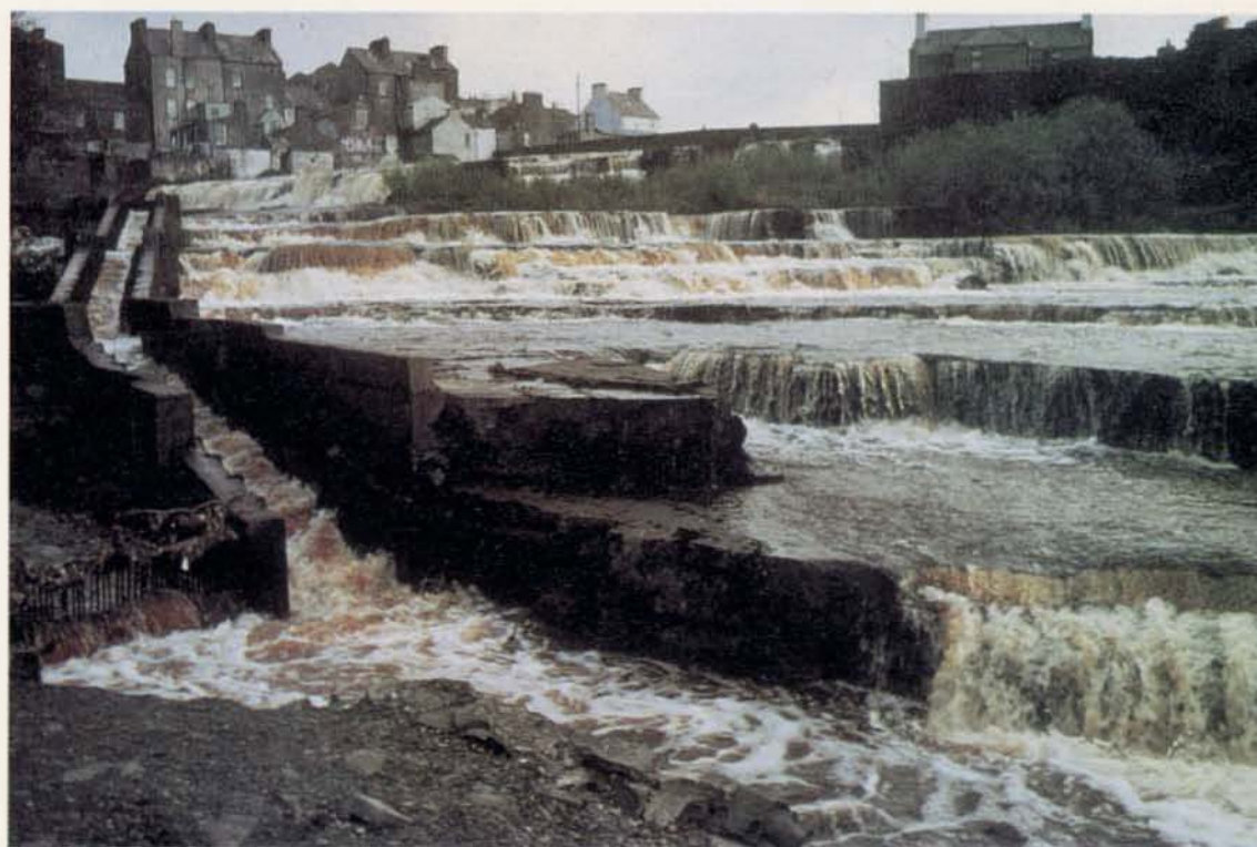
8 - Ennistymon Falls, River Inagh (Ireland): veduta generale del complesso di cascate e del sistema di Denil fish passes che le attraversa. La parte superiore (foto n. 9) della scala è localizzata nella parte centrale della prima cascata ed è stata realizzata con accorgimenti i cui particolari sono evidenziati nella foto n. 10.
