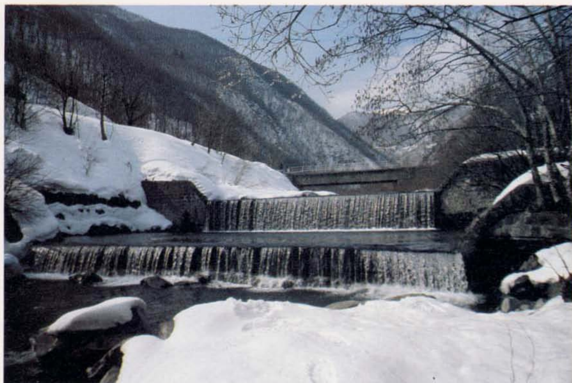
28 - T. Dolo (Secchia), Fontanaluccia: due piccole traverse (dislivello complessivo 2.5 m ca.) dividono un lago da diversi km di torrente ancora liberi di briglie.
