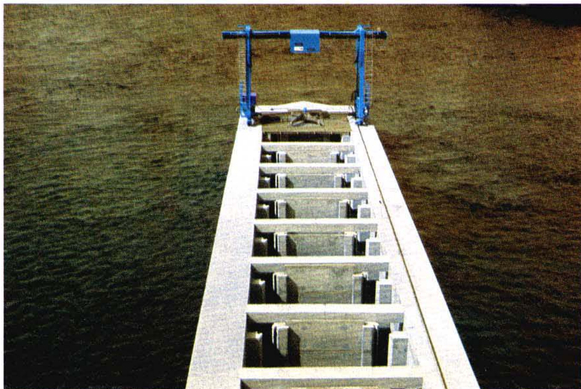
13 - Fl. Loire (France): passe à bassins successifs à fentes verticales per salmoni, trote di mare, ciprinidi
