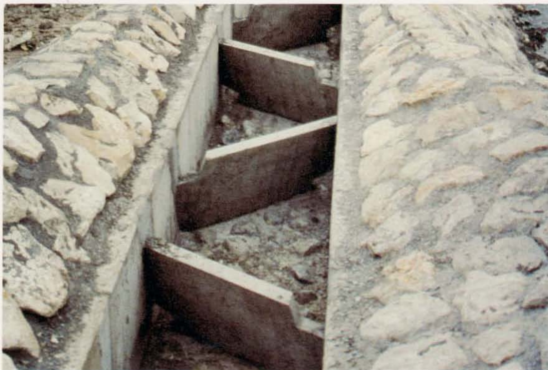
20 - Particolare di un "rhomboid fish pass" in costruzione: questo modello, con alcune varianti sui pannelli che possono anche toccarsi alle estremità, è quello più usato attualmente nel Baden-W.
