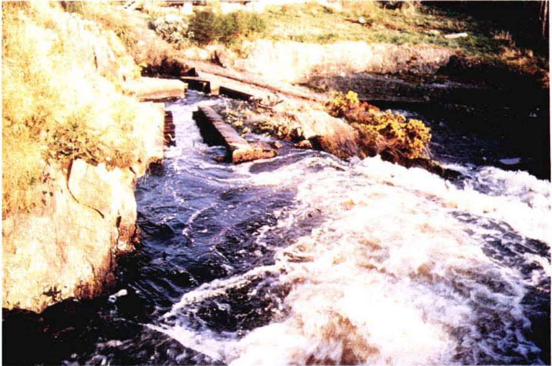
5 - Clifden Weir, (Ireland): Denil fish passes in serie inframezzati da una piscina di riposo:
