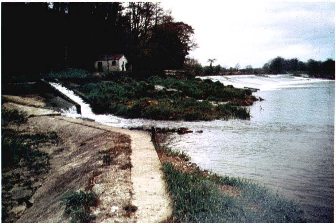
6 - Clondulane Weir, River Blackwater (Ireland): Denil fish pass dotato anche di fish counter automatico.
