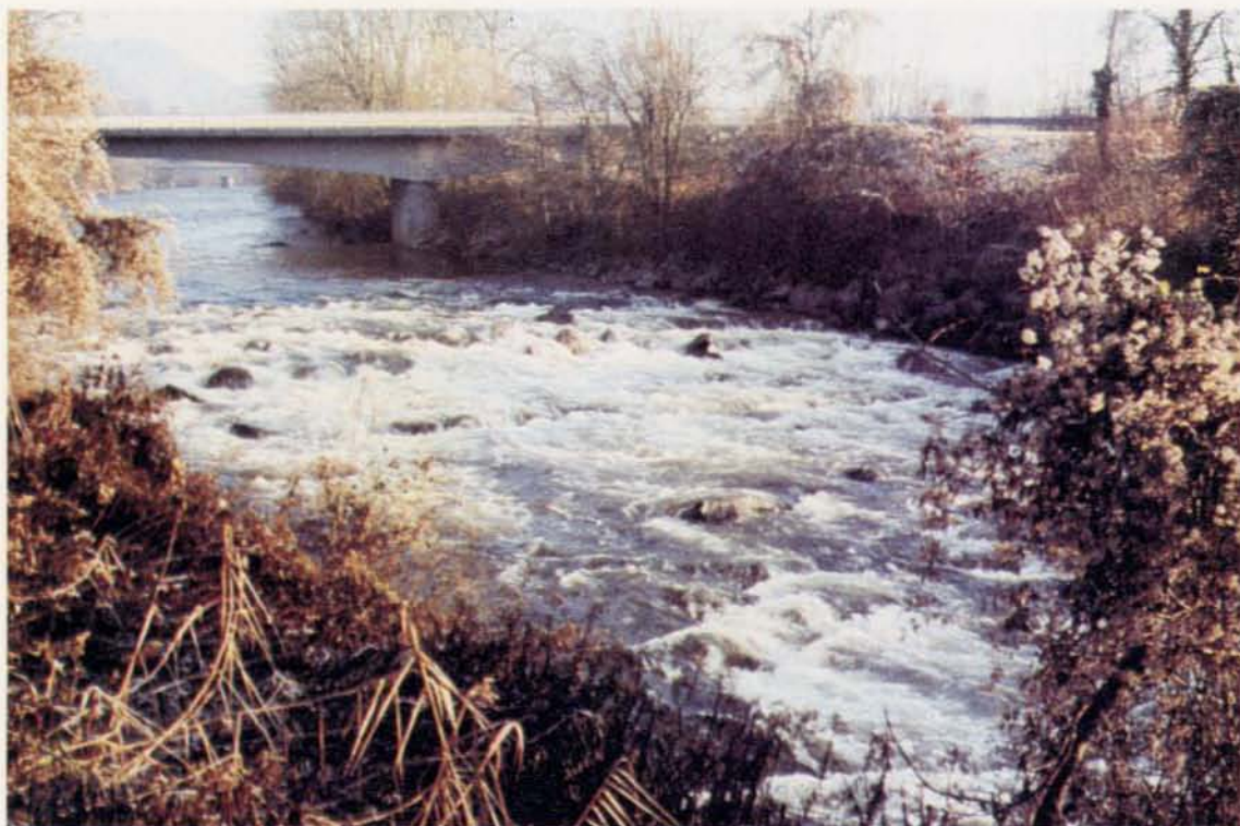
23 - Traversa "Rauhe Rampe": il dislivello è di oltre tre metri ma la sua particolare conformazione, oltre a garantire una duratura stabilità all'alveo, può essere superata da ogni tipo di pesce. Queste rapide artificiali sono quindi preferite e realizzate ovunque sia possibile.
