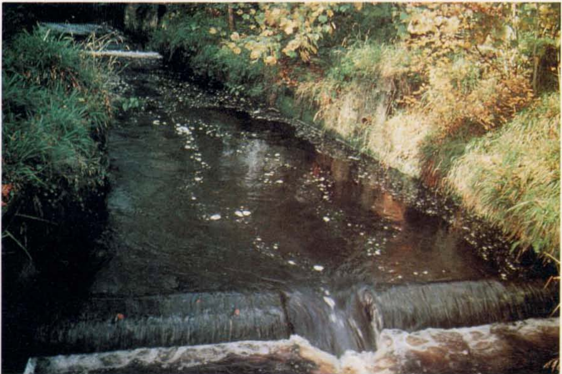
4 - Warkworth fish pass, River Coquet (UK): particolare dell'ingresso alla "pool and traverse fish pass" aggiunta alla traversa della foto n. 3
