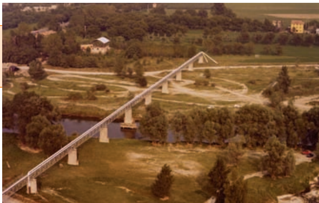
MUZZIOLI (MODENA) - 1981. L'area che entro pochi anni sarebbe stata assoggettata a escavazione è immediatamente a ridosso del ponte del metanodotto tra Marzaglia e Rubiera sul fiume Secchia. (Foto Archivio Ufficio Attività Estrattive).
