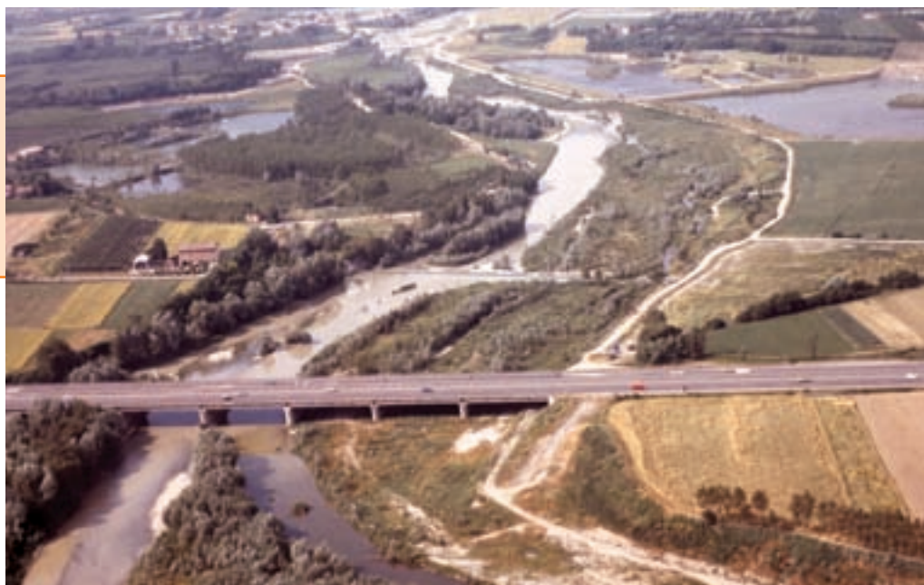
CASSA DI ESPANSIONE DEL PANARO (MODENA - S. CESARIO) - 1982. La Cassa di Espansione fu progettata in funzione delle esigenze idrauliche del bacino del Fiume Panaro e ha comportato il recupero delle aree di cava situate a monte del manufatto regolatore come bacini di accumulo delle acque di laminazione durante le piene. (Foto Archivio Ufficio Attività Estrattive).
