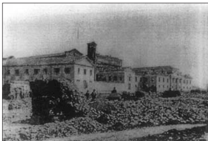
1918-1919. I lavori di abbattimento delle mura, all'altezza del Baluardo di S. Pietro, nel tratto fronteggiante la caserma Garibaldi; a sinistra della fotografia la Caserma Fanti.
